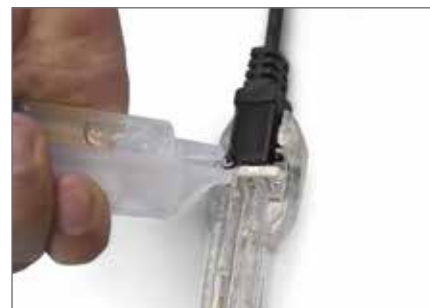
PASO 2 Aplicar sellador o silicón en frío (se recomienda marca DEVCON®)
